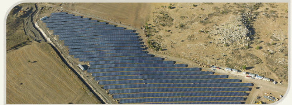
Tefenni 3mW Solar Power Plant > Burdur - Türkiye
