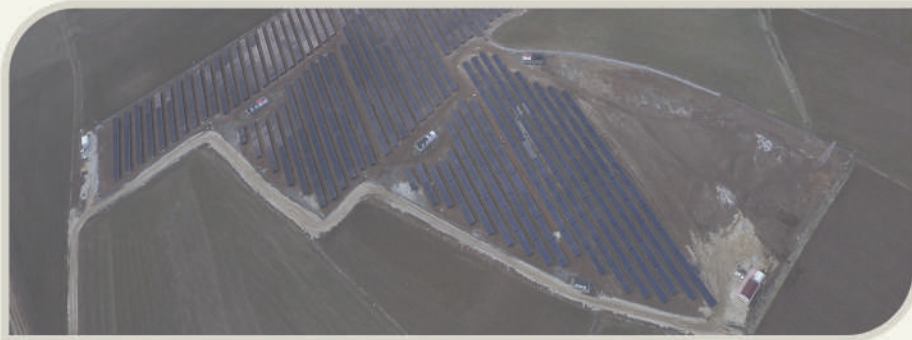
Akfen 5 mW Solar Power Plant > Tokat - Türkiye
