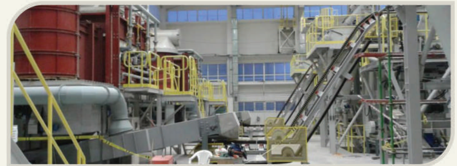
Eti Maden Boron Oxide Plant > .Balıkesir - Türkiye
